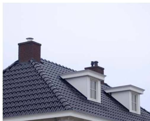
Bij schoorstenen en dakkapellen
